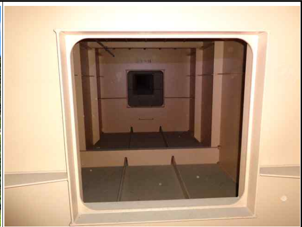
거더 내부 외관조사(도보)
