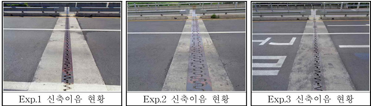
【그림 3.22】 신축이음장치 현황 및 외관조사
