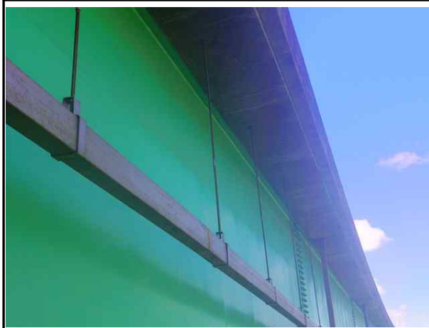
배수관 외관조사(교량점검차, 도보)
