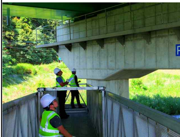
거더외부 외관조사(교량점검차, 도보)
